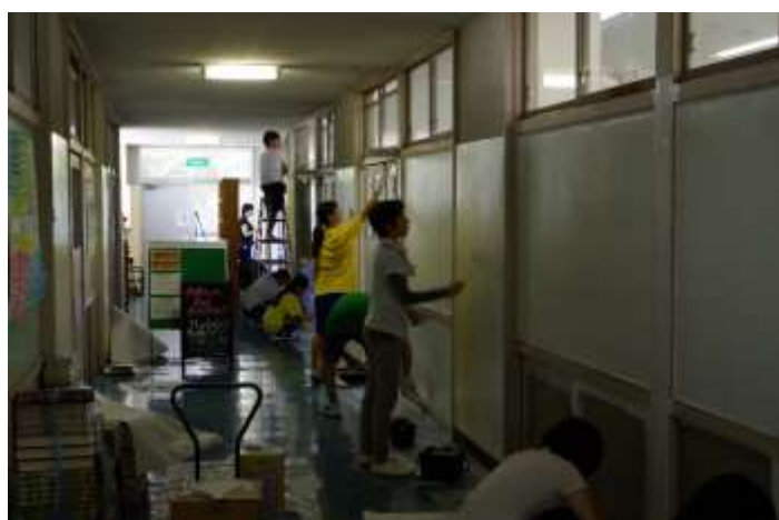
図書室外側のペンキ塗り
